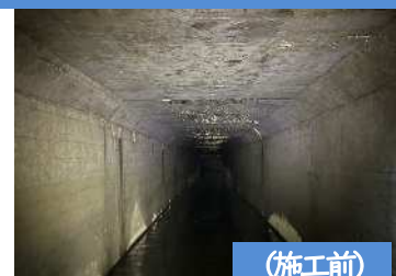
雨水幹線改築(松尾1号雨水幹線)
